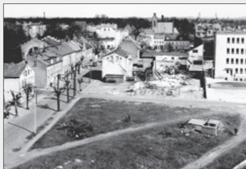
▲ Na zdjęciu z prawej strony fragment Przychodni Obwodowej w Swinoujściu w ostatniej fazie budowy.
