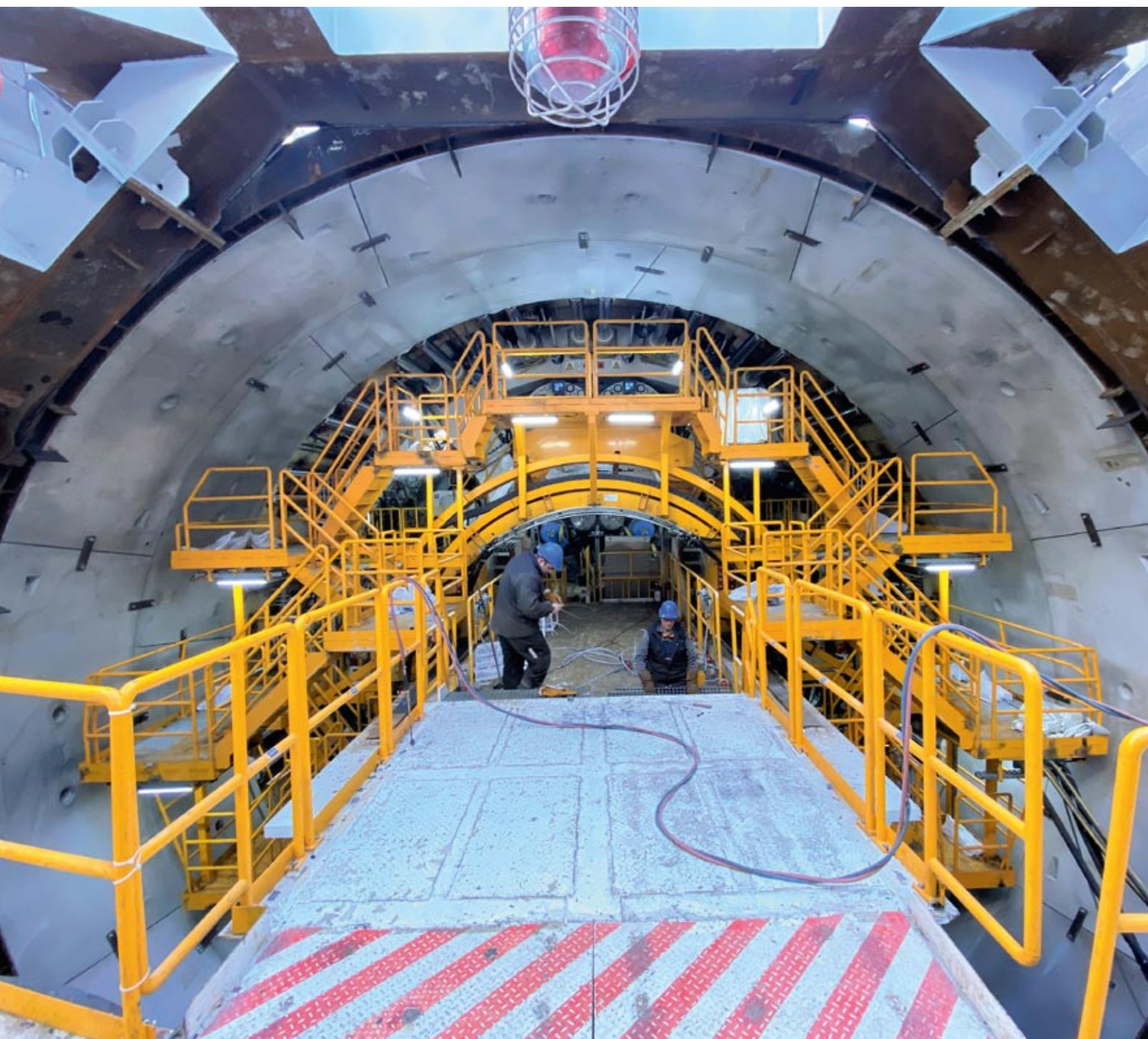
■ Wnętrze TBM. Wokół widać już ułożone elementy obudowy tunelu.
